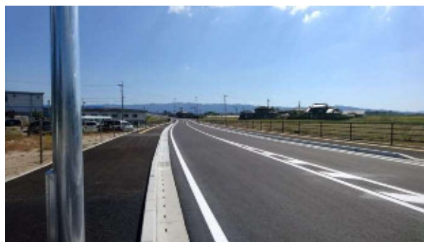
写真 県道鳥栖朝倉線バイパス開通式直前
