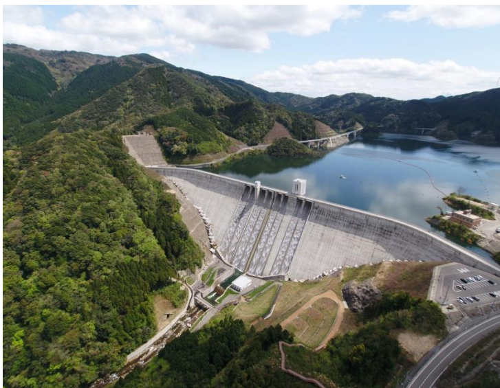
写真 1：五ヶ山ダム（令和 2 年 4 月 20 日撮影）
