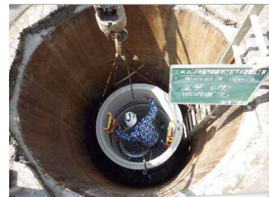
組立マンホール工
