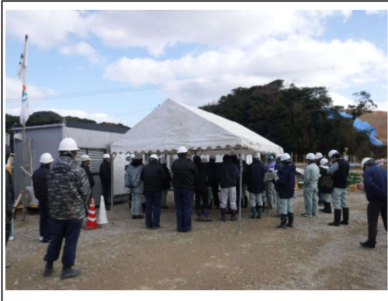
現場見学会の状況 福岡志摩前原線 ICT土工
